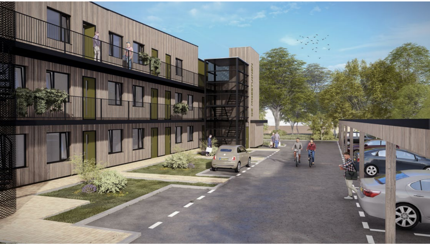
Achterzijde van het gebouw. Met de lift en de parkeerplaatsen duidelijk zichtbaar
